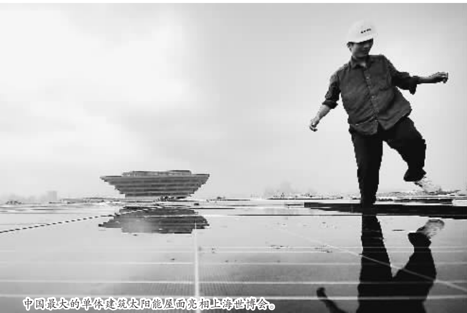
中国最大的单体建筑太阳能屋面亮相上海世博会。
